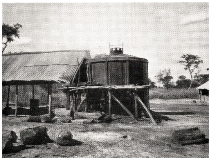
Fig. 5 Aspect du chantier.
