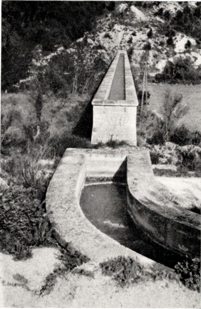
Fig. 10 — Plaine de la Crau, aqueduc et siphon de la Vallée des Baux.
