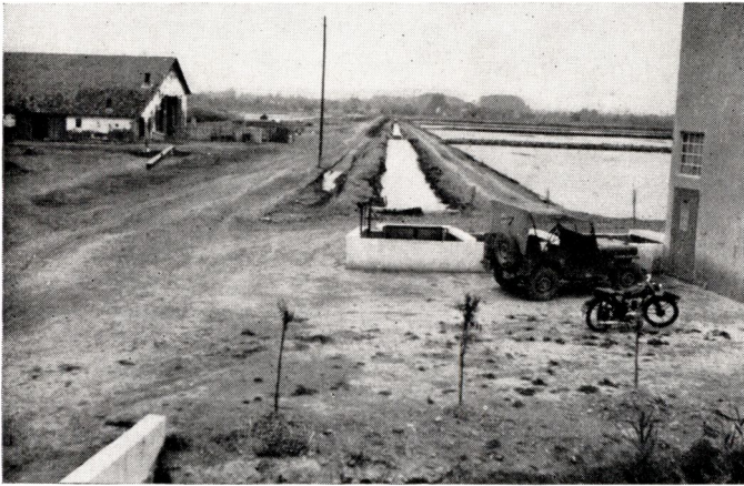
Fig. 7 — Canal principal d'irrigation longeant des rizières submergées. A droite, à l'avant-plan, la station de pompage.
