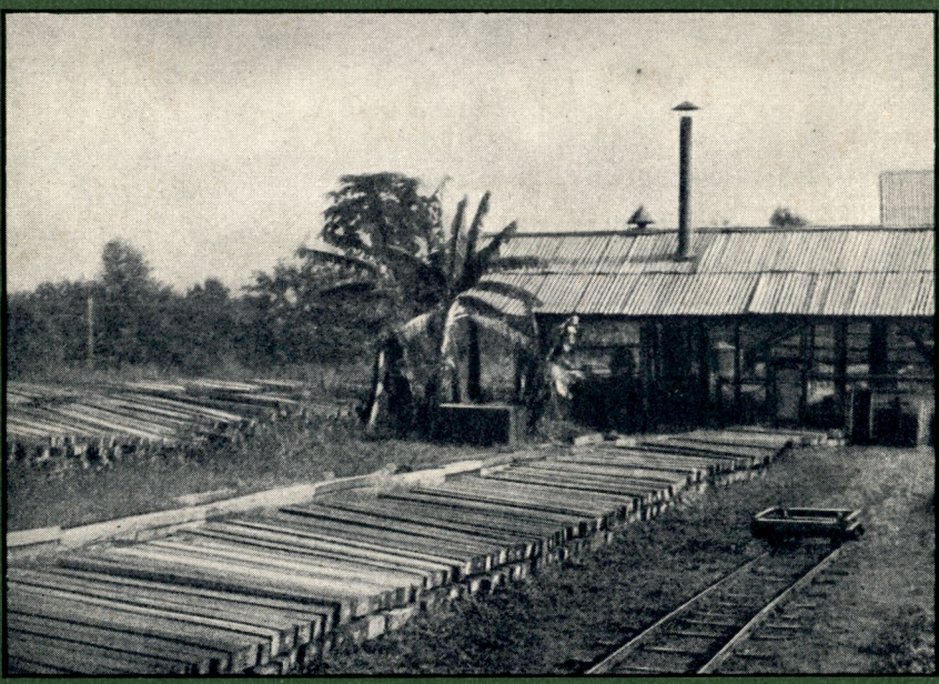
Photo C.F.L. Stanleyville (Km 25) — Installation d'imprégnation de traverses de chemin de fer par le procédé LEBACQ
