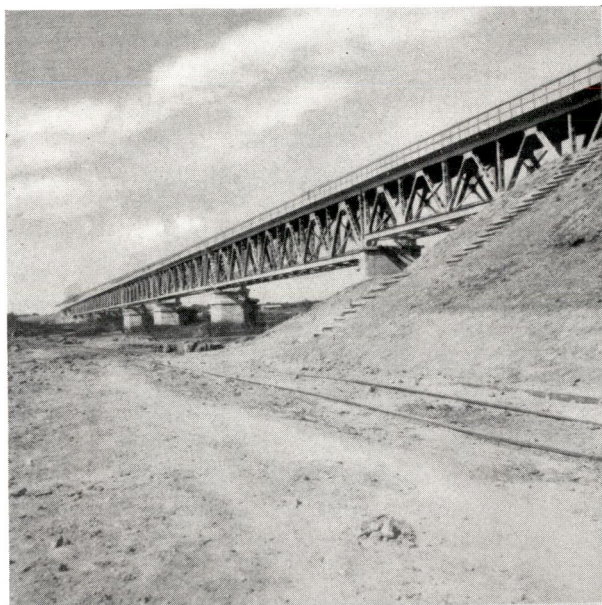
Fig. 2 — Nouveau pont sur le fleuve Lualaba, assurant la jonction ferroviaire Kabalo-Kamina
