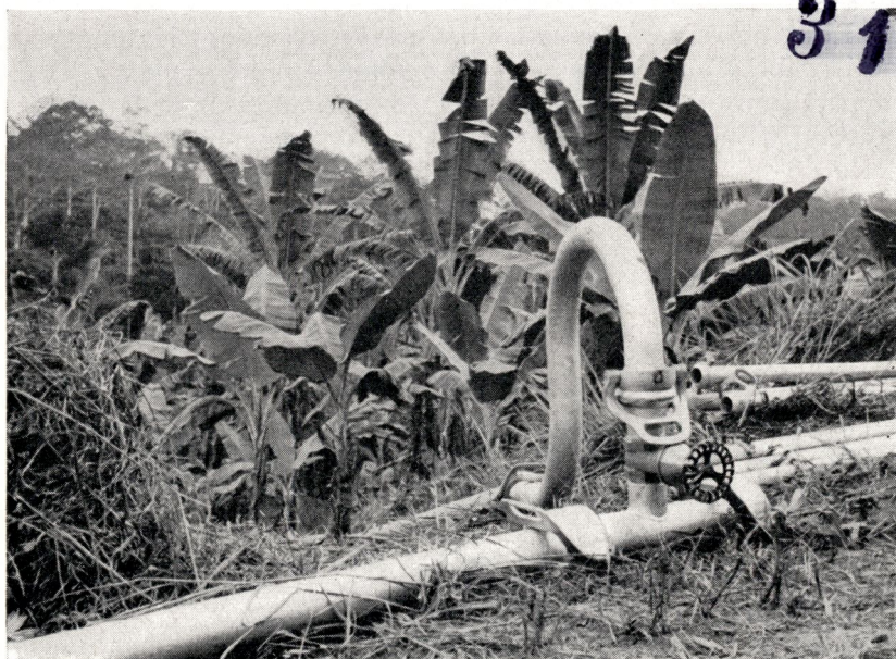
Photo 4 — Conduite principale et raccord en col de cygne dans une plantation de bananier au Mayumbe (Mannesmann)
