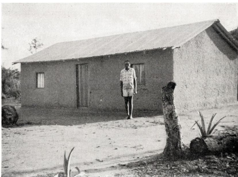
Photo 20 — Maison de 34 m 2 avec murs en pisé et toiture en tôles d'aluminium d'un coût de 3.600 fr, entièrement construite par le planteur. Cette formule de logement, quelque peu modifiée, semble très heureuse dans les conditions actuelles
