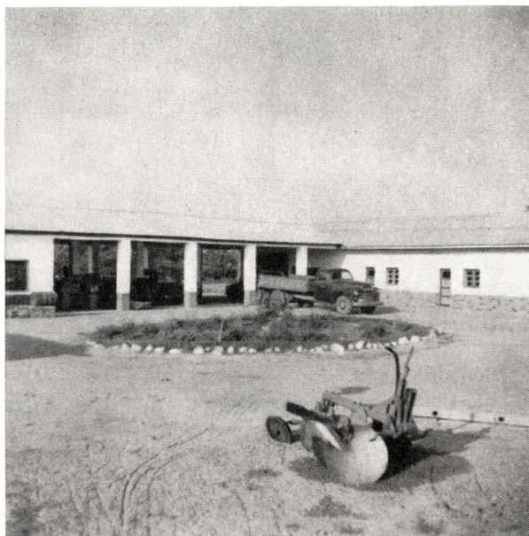
Fig. 11 — Installations du paysannat à Kasongo. Vue d'ensemble des bureaux et du garage.
