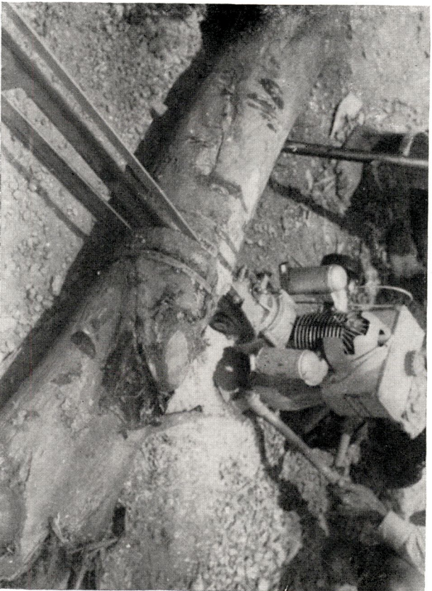
Fig. 3 — Tronçonnage et mise à longueur du poteau
