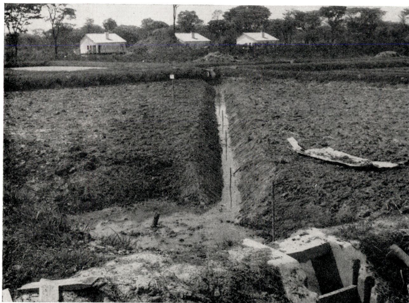
Fig. 29 — L'aménagement des refuges : la tranchée joignant la prise d'eau à la digue percée et le refuge d'aval de 60 cm de profondeur ; au premier plan, la digue percée.
