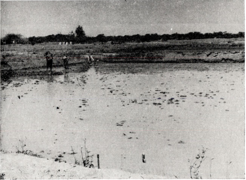
Fig. 8 — L'émottage et le nivellement sous eau.
