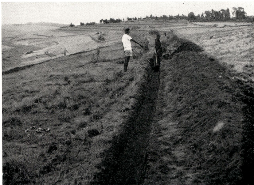
Fig. 24 — On creuse un fossé le long d'une courbe de niveau en jetant la terre vers l'amont ; on maintiendra cette terre en y bouturant du Pennisetum ; à la longue cette haie antiérosive va former une terrasse
