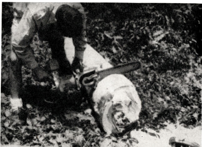
Fig. 3 — Après abattage, les poteaux sont coupés aux diamètres et longueurs exactes à l'aide d'une scie à chaîne; une section bien nette est exigée
