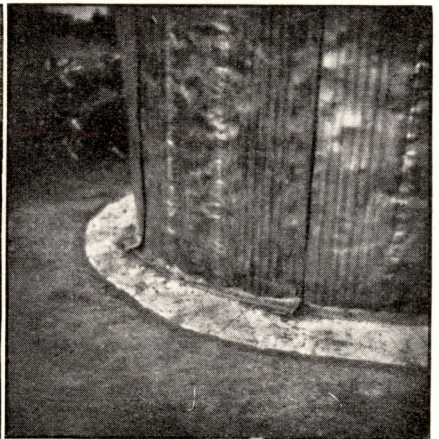
Fig. 8. Silo V. Le bord inférieur de la hausse est replié en dehors et repose sur la marge, simplement enduite d'argile, en continuité avec le crépissage de la paroi.
