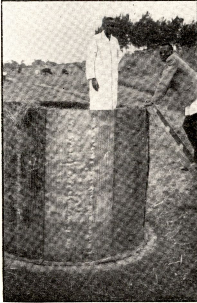
Fig. 6. Silo II en maçonnerie, surmonté de la hausse et chargé, vers le 10 e jour.
