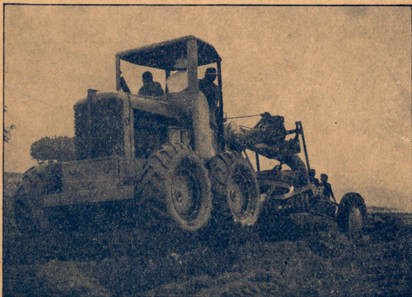
Niveleuse Allis-Chalmers AD4 pour la construction de terrasses (Cogerco).
