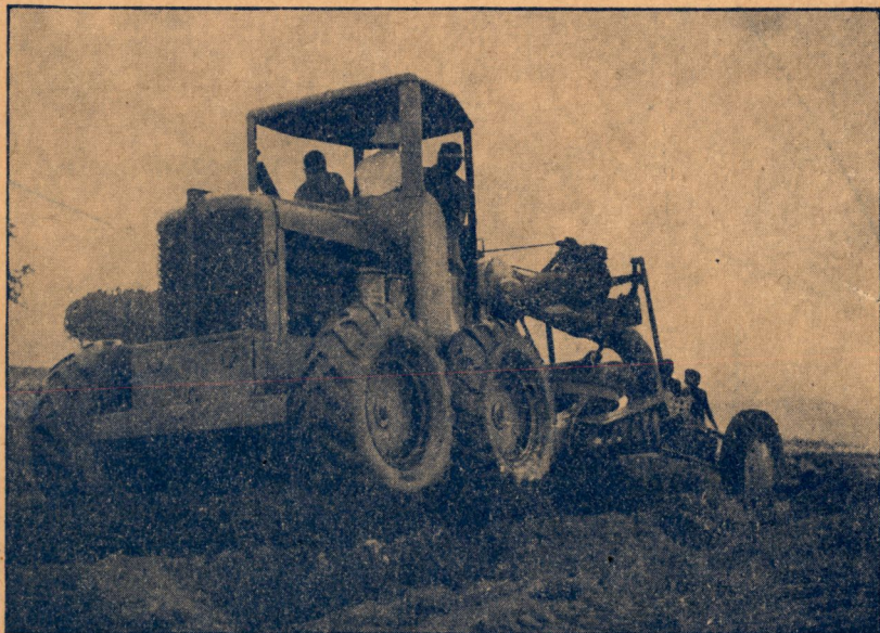
Niveleuse Allis-Chalmers AD4 pour la construction de terrasses (Cogerco).
