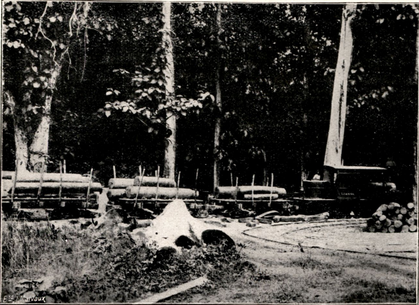
Fig. 66. — Transport des grumes par wagonnets et locomotive.
