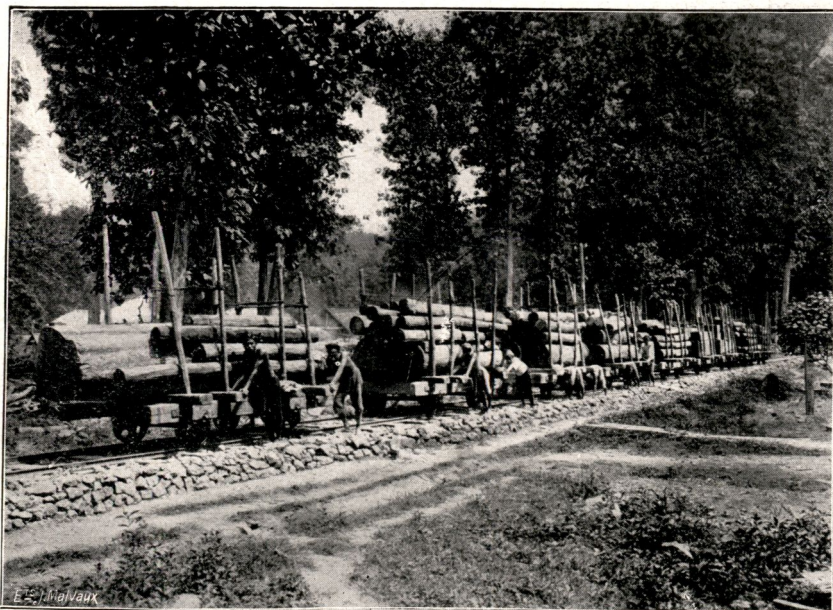
Fig. 65. — Transport des grumes par lorries : wagonnets poussés par les indigènes.
