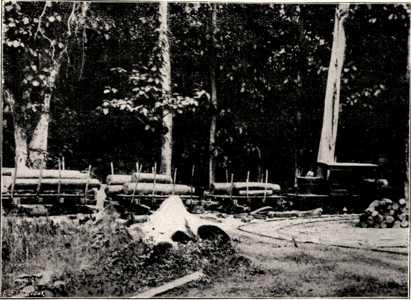
Fig. 66. — Transport des grumes par wagonnets et locomotive.
