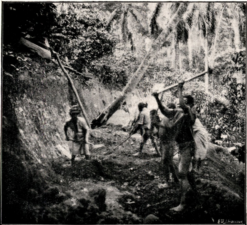
Fig. 53. — Construction d'une route reliant entre elles les plantations de la Compagnie de Cazengo. (Photo Janssens.)
